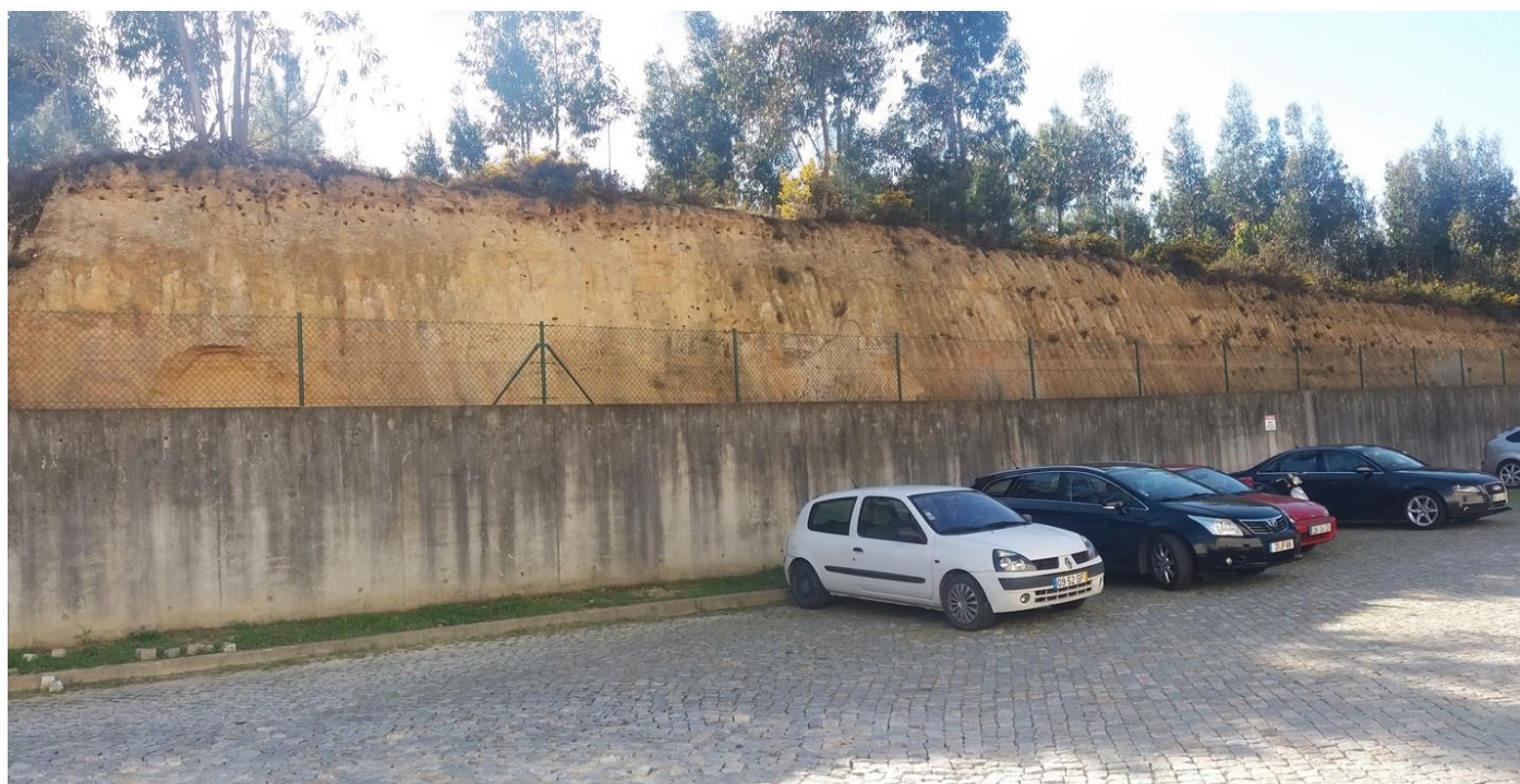
Figura 74: Vista de corte nos depósitos pleistocénicos provocado por desaterro necessário para a construção da plataforma de assentamento das instalações industriais.
