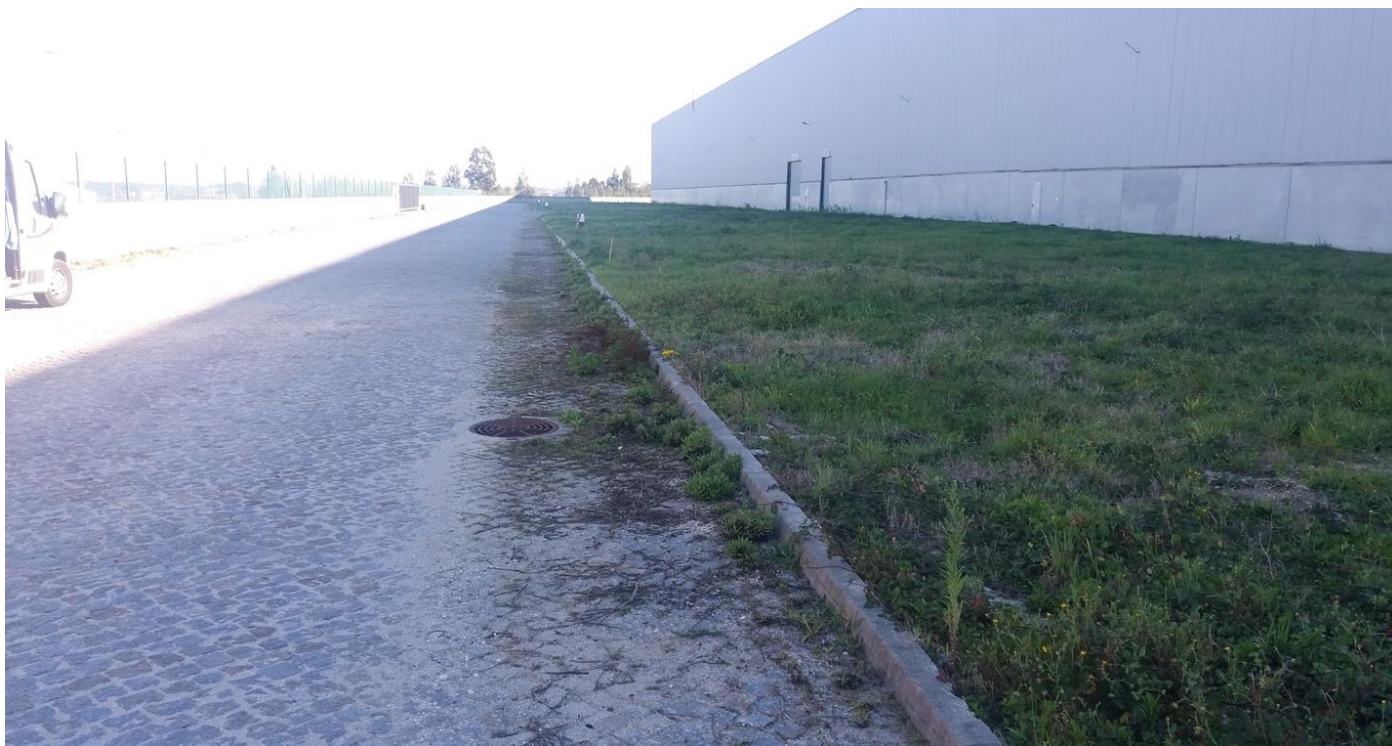
Figura 75: Vista de área impermeabilizada situada no lado norte das instalações.
