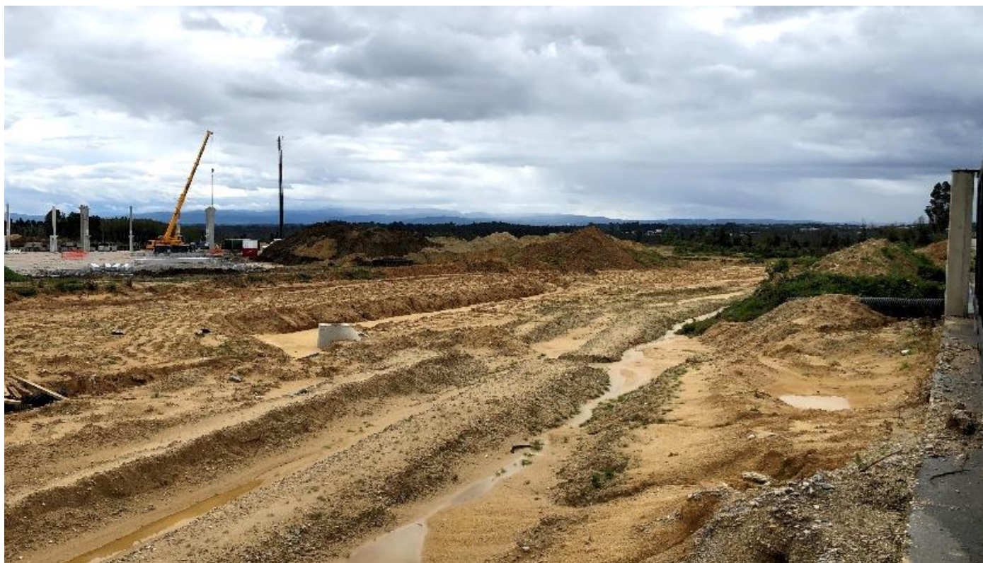
Figura 67: Áreas artificializadas (área em construção) na área de estudo.
