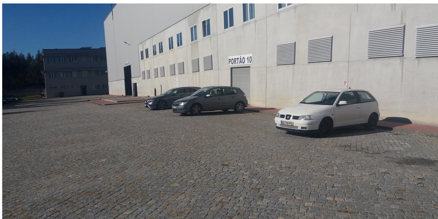
Figura 73: Vista de área impermeabilizada situada no lado sul das instalações. Ao fundo, o edifício administrativo.
