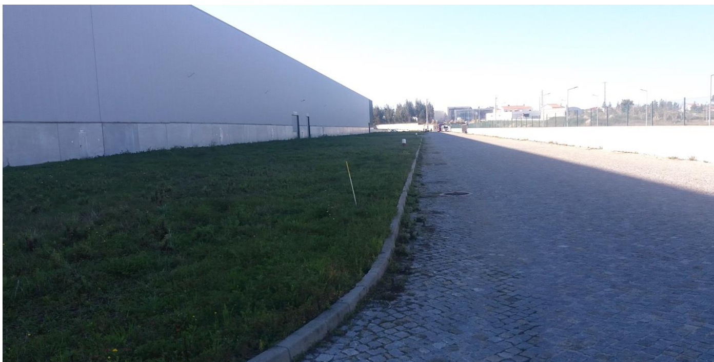
Figura 76: Vista de área impermeabilizada situada no lado norte das instalações. Ao fundo, o edifício da portaria.
